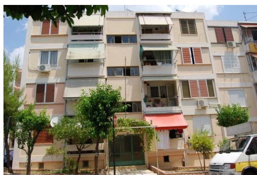
Εικόνα 7 ΝΔ όψη (οδός Κολοκυθά)
